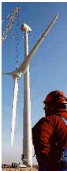
Construcción de un aerogenerador. :: P. R.
