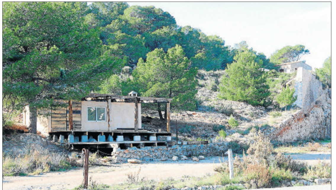
La construcción se ubica junto a la explanada donde antiguamente se amontonaba la sal. VICENT MARÍ
